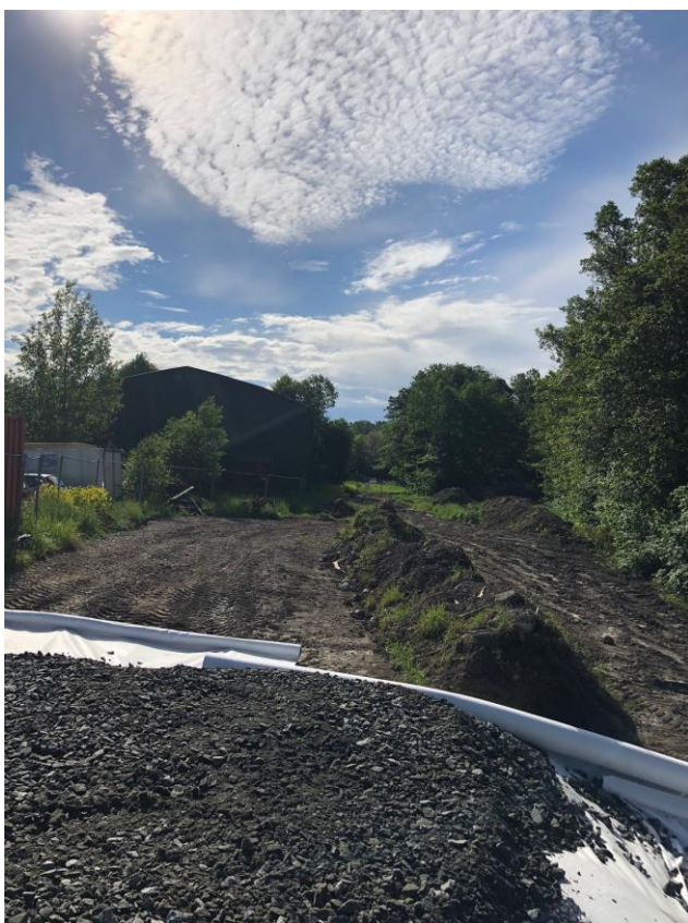
Bild: Förarbeten till den nya gång och cykelvägen
